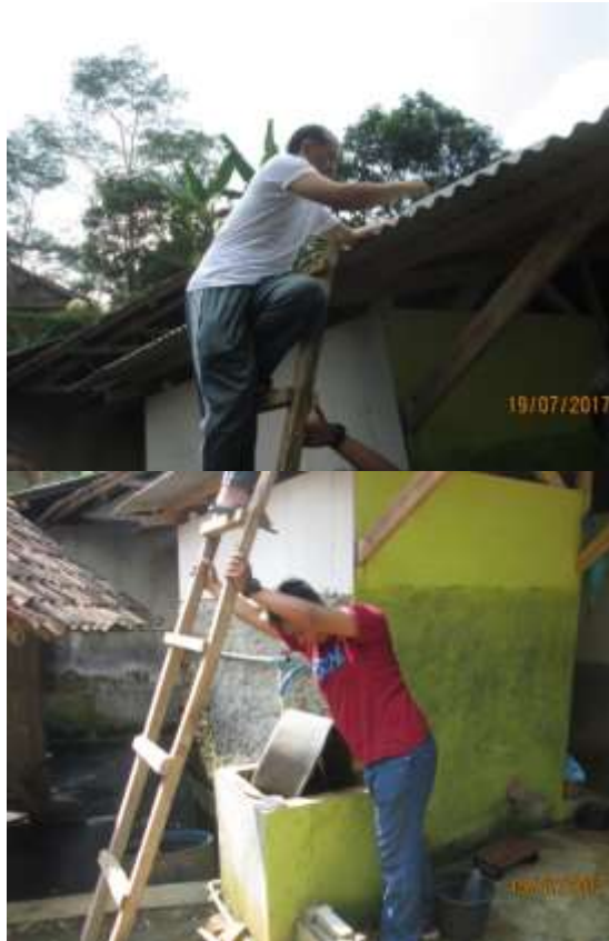
Pemasagan modul sel surya di atap rumah
