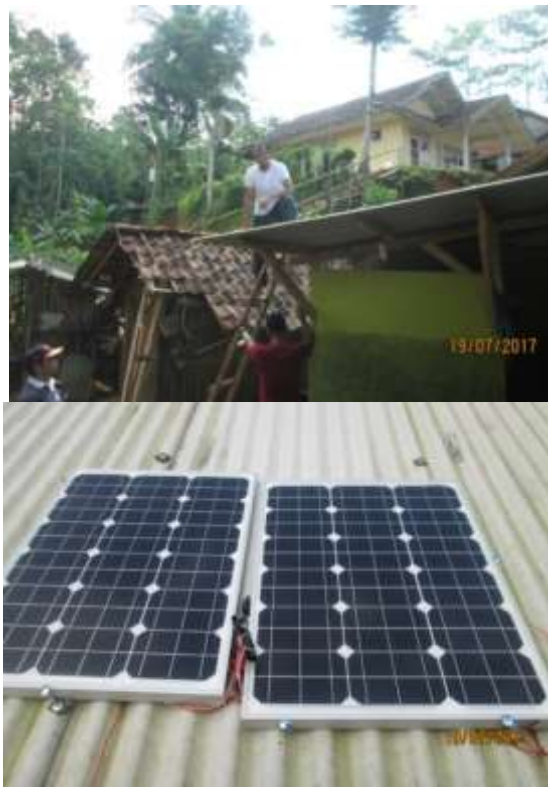
Dua modul sel surya dipasang secara paralel
