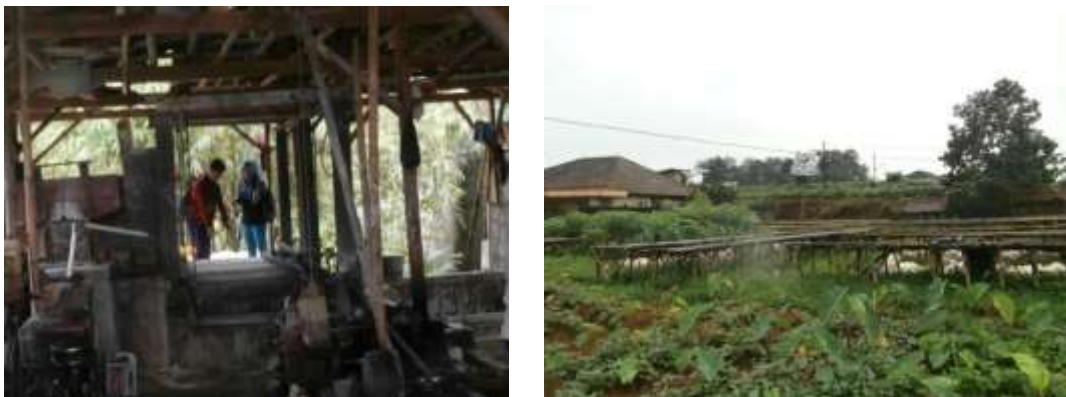
Gambar 1. Pabrik dan tempat penjemuran Tapioka
