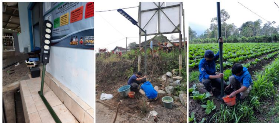
Gambar 4. Perakitan dan Instalasi Lampu Surya
