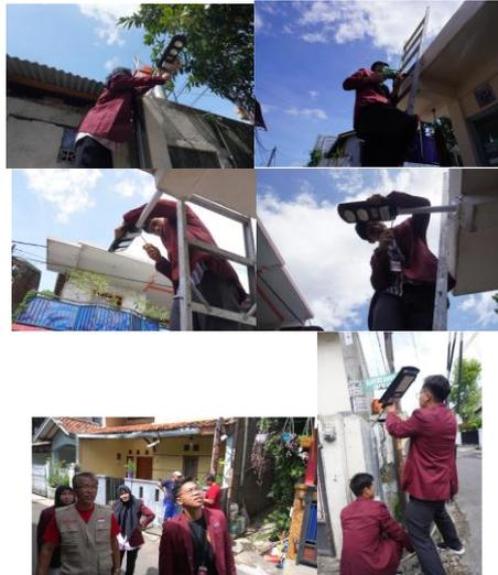
Gambar 9 Pemasangan lampu penerangan jalan umum sel surya di beberapa RT dibantu oleh mahasiswa D3 Teknologi Telekomunikasi dan S1 Teknik Elektro Universitas Telkom
