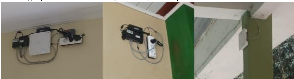
Gambar 3. Tampilan access point yang telah dipasang
