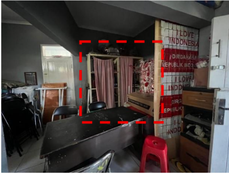
Gambar 1. Kondisi Ruangan Posyandu dan Fasilitas Simpan Existing
