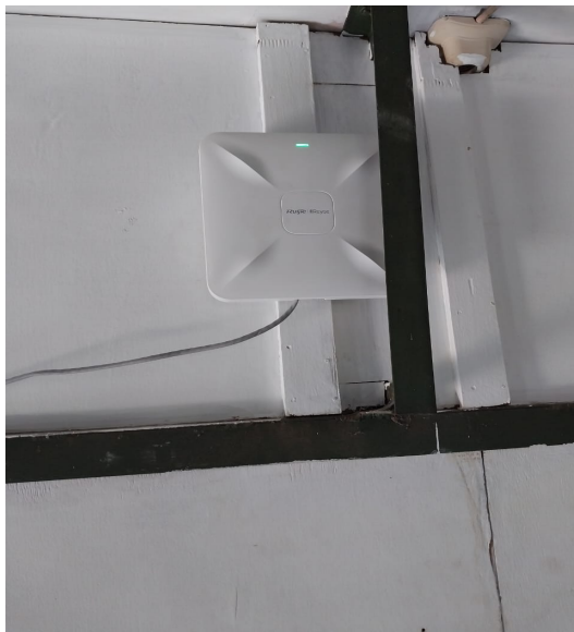
Gambar 6. Pemasangan dan Instalasi Perangkat Router
