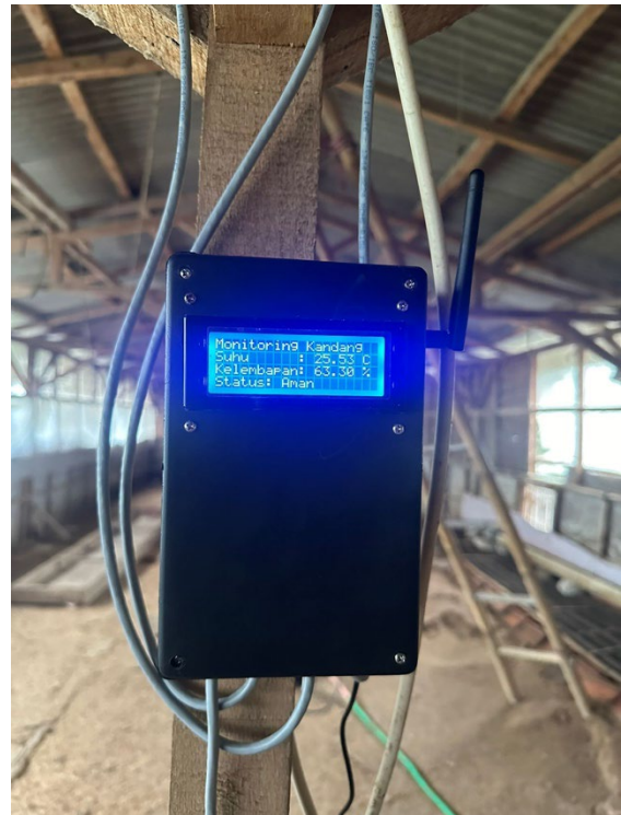
Gambar 5 Lokasi Pemasangan Alat
