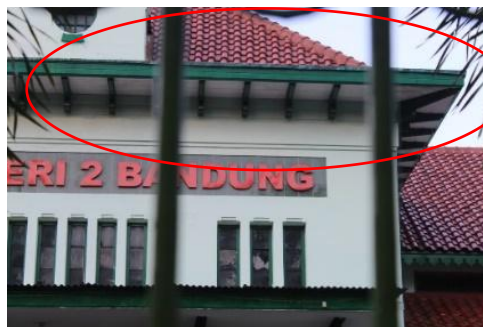
Gambar 5. Gedung sekolah SMPN 2 Bandung pada masa lalu (sumber : dokumentasi pribadi 2020)
