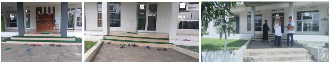
Gambar 1. Kondisi eksisting entrance Masjid Al Huda Cluster Rancamanyar
