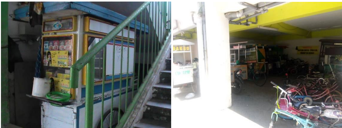
Gambar 6 : Pemanfaatan Ruang pada Rusunawa yang Tidak Sesuai Fungsinya
