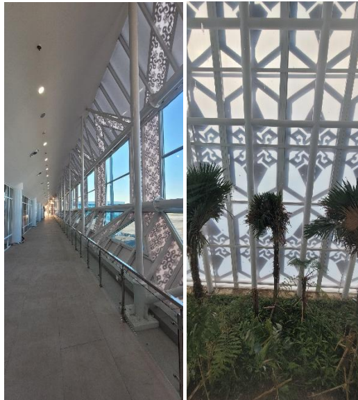
Gambar 15. (b). Pencahayaan secara hybrid pada ruang tunggu Bandara dengan menggabungkan antara alami dan buatan sebagai upaya efisiensi energi
