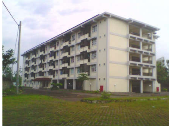
Gambar.2 Bangunan Blok B Rusunawa Panggungharjo, Bantul, Yogyakarta
