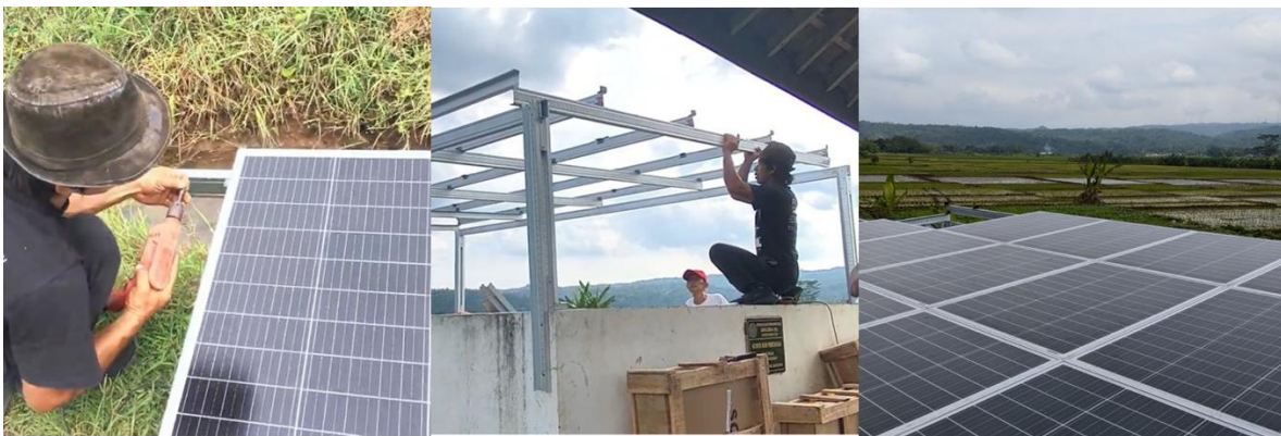
Gambar 8. Proses pemasangan panel surya
