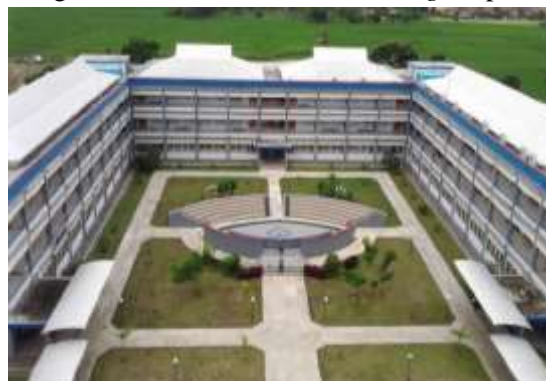
Gambar 12. Lokasi pengujian remote
