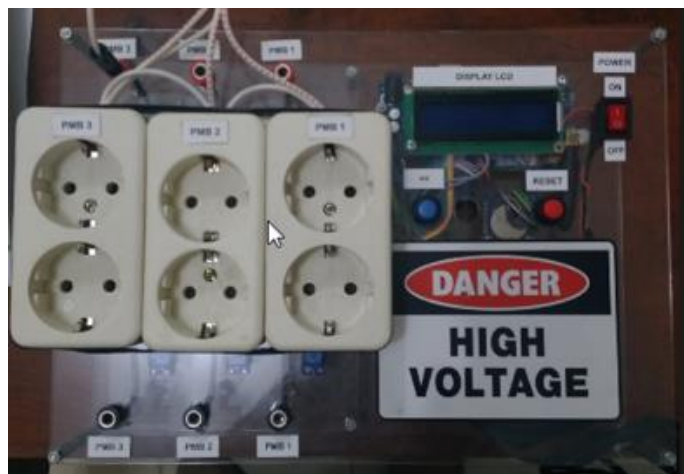
Gambar 7. Prototipe sistem telemonitoring gangguan pada jaringan listrik
