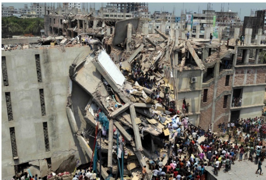
Gambar 1 Runtuhnya Rana Plaza pada tahun 2013 (Sumber: www.corpgov.net diakses 28 September 2018 pukul 10.30)
