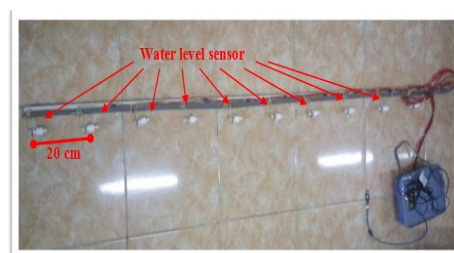
Gambar 6. Pemasangan Sensor pada Tiang Palembang
